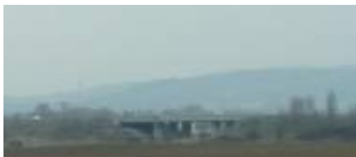
Chabrilan, pont de la D104 passant au-dessus de la voie ferrée Valence-Die-Veynes
