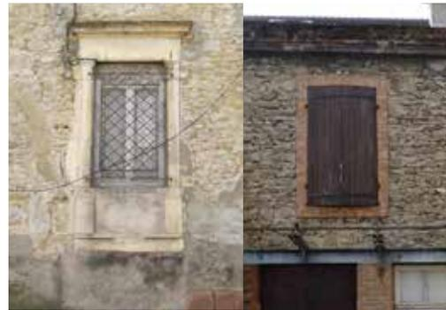
← **Des parements issus du sous-sol:** Des constructions traditionnelles bâties en moellons calcaires. Ceux-ci donnent cet aspect beige clair, roux, et gris aux constructions. Ils étaient généralement enduits; la pierre de taille étant utilisée pour les linteaux et les jambages, ainsi que les portails.
