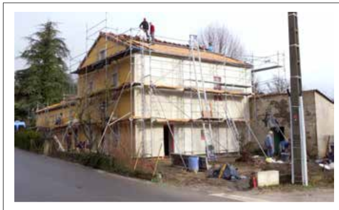
Une des maisons rénovées dans le cadre de l'accompagnement par la Plateforme de rénovation Biovallée-Energie.
