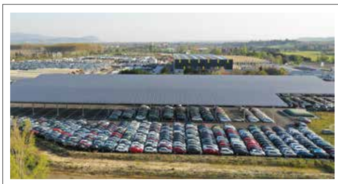
L'entreprise GPA (Livron) a installé des panneaux photovoltaïques.
