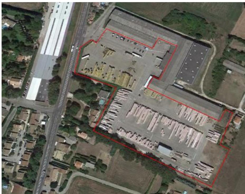
Figure 77: Vue aérienne d'un parking pouvant accueillir des panneaux photovoltaïques en ombrière
