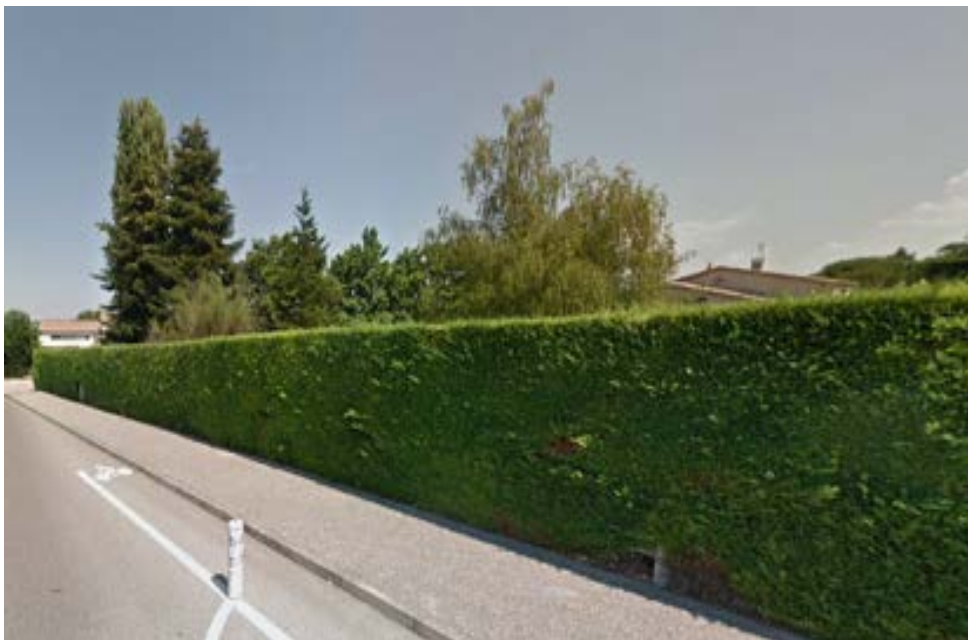
Localisation de l'OAP Montée du Beffroi / Vue depuis la montée du Beffroi
