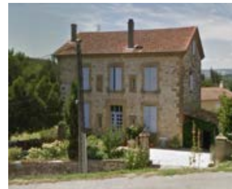
Vue depuis la rue du lavoir
