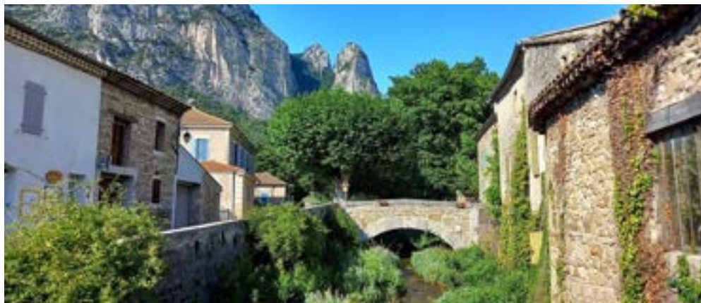
Localisation de l'OAP / Vue vers le pont de la Vèbre
