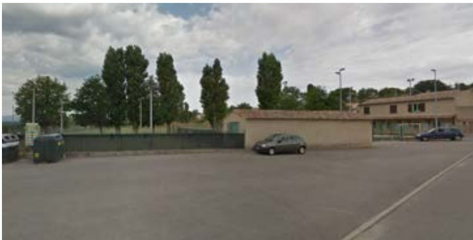
Localisation de l'OAP Stade / Vue depuis la route du Stade
