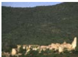
Cobonne, village perché sur crête
