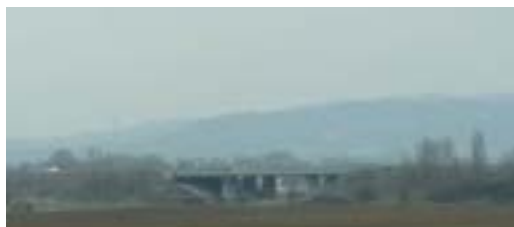
Chabrillan, pont de la D104 passant au-dessus de la voie ferrée Valence-Die-Veynes
