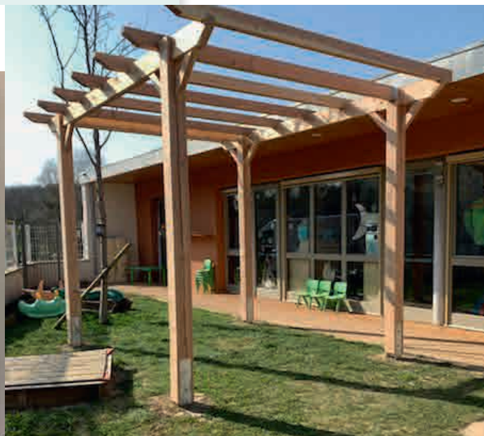
Installation de la pergola à la micro-crèche de Soyans
