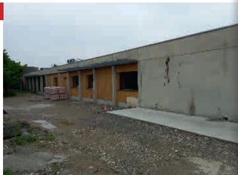
Les travaux de la cuisine centrale ont été lancés sur l'Écosite du Val de Drôme.
