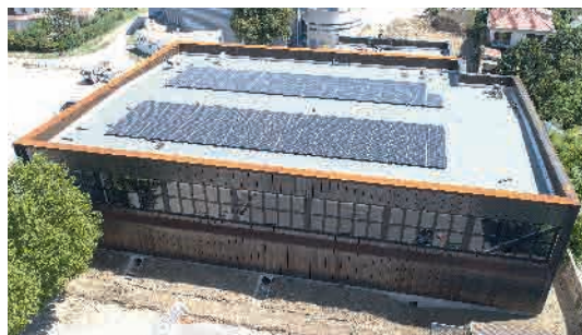
Le centre sportif intercommunal du Val de Drôme, à Loriol-sur-Drôme, réceptionné en septembre 2022.
