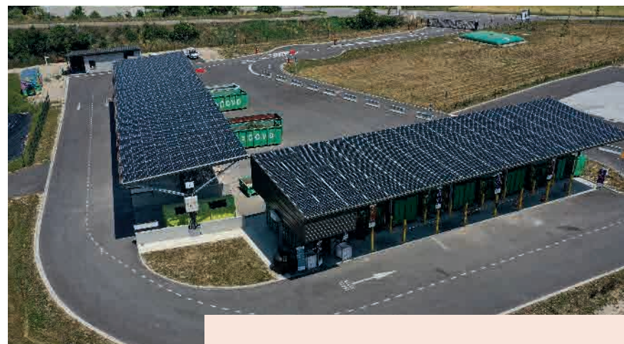
La nouvelle déchetterie intercommunale de Livron est équipée de panneaux photovoltaïques pour une production de 150 kWc.
