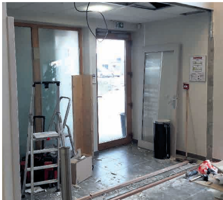
Travaux de l'espace France services au siège de l'Intercommunalité
