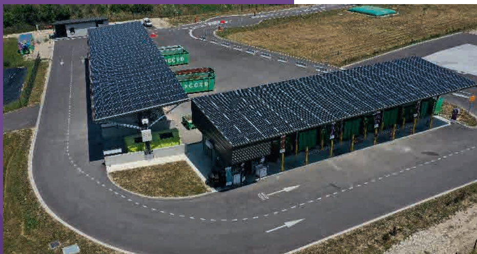
Vue aérienne de la déchetterie intercommunale de Livron.
